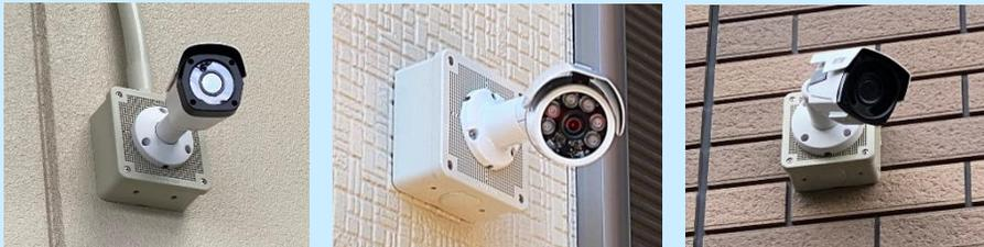
外壁に端子BOXを付けてその上にカメラを取付する躯体に優しい取付方法をお勧め致します
